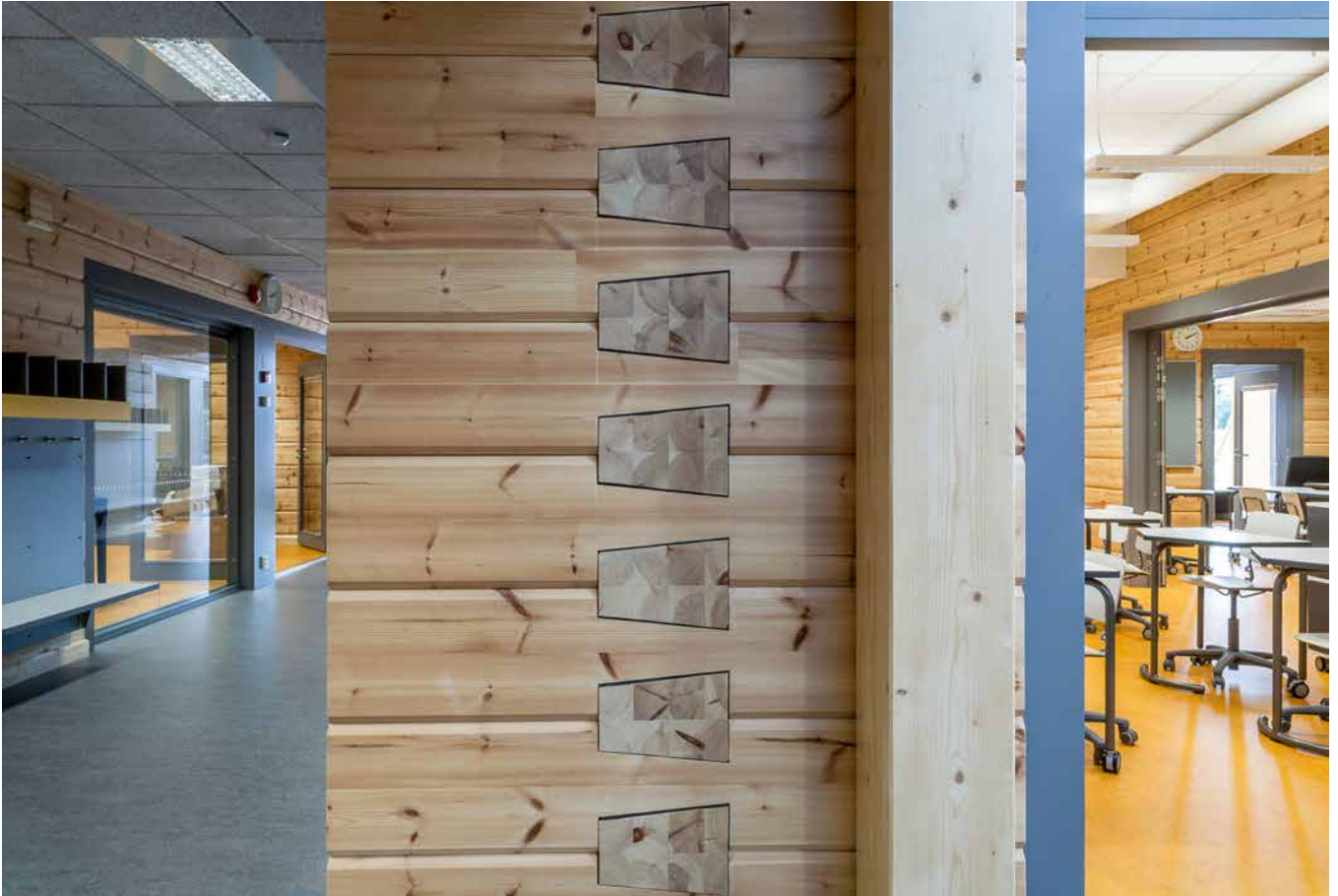
Kuva 21. Pudasjärven hirsikampuksen sisätiloissa on näkyviä lohenvyöryävalvoksia. Kuvassa on ns. T-liitos. Lamellihirren pääty poikkeaa hieman ilmeeltään ristiinlaminoitujen hirren päädyistä. Hirsien välisen sauman näkyvä viiste on melko suuri.
