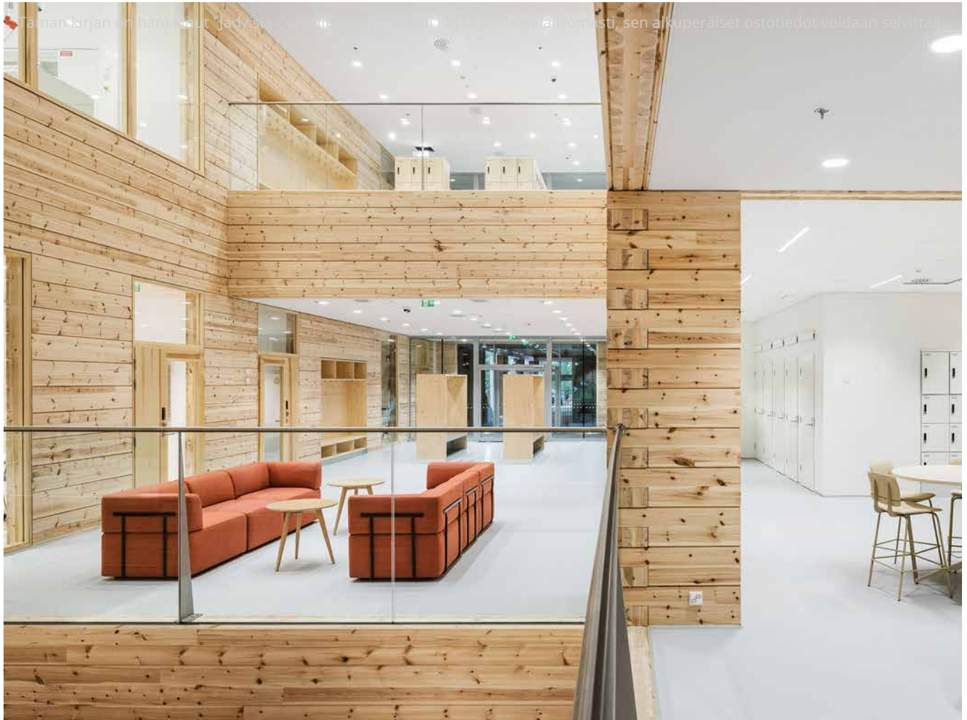
Kuva 19. Painumattoman hirsirungon nurkkaliitoksia on jätetty näkyviin Lukio ja kulttuuritalo Monion sisätiloissa, vaikka ulkona hirsien päädyt ovat jiirinurkkien myötä piilossa. Pelkistetty, hirren tasakertoihin sopiva näkyvä tasanurkkatyyppi on kehitetty kyseistä rakennusta varten. Toinen tätä kohdetta varten kehitetty erikoisliitos liittyy kohteen rakentamiseen lohkoissa. Lohkot yhdistävät "siltahirret" tuli voida asentaa vasta seinien pystyttämisen jälkeen. (Lohkoissa rakentaminen, ks. myös luku 6.3.)
