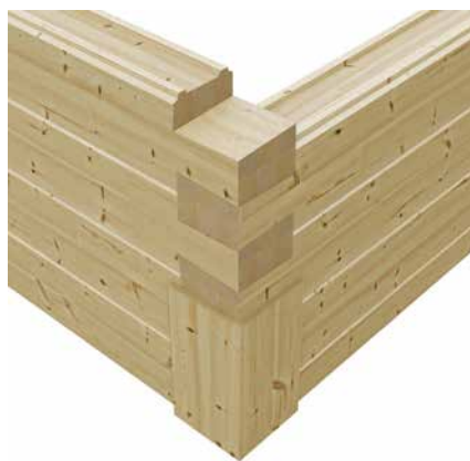
Kuva 17. Lohenpyrstönurkka (tai mm. tirolilaisnurkka) on yksi tasanurkan tyyppi.
