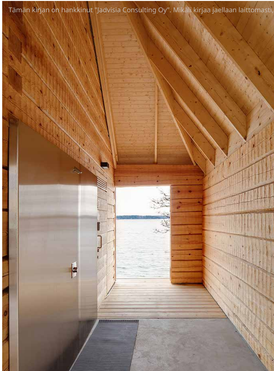
Kuva 3. Lonnan Saunan hirsirunko on käsinveistettyä, yksipuista kirveellä piiluttua hirttä.
