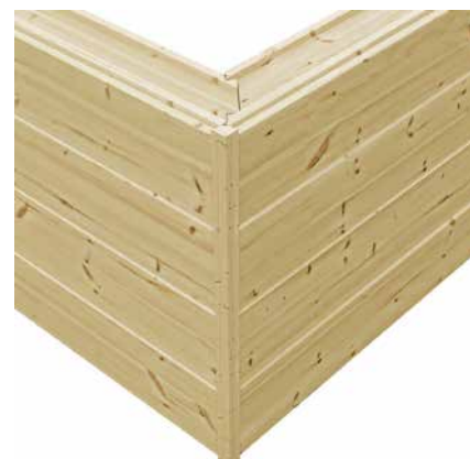
Kuva 18. Jiirinurkka (tai mm. citynurkka) on tyyppiltään tasanurkka, joka perustuu lohenpyrstöliitokseen nurkan sisällä. Jiirin ulkonurkka usein listoitetaan säännestävyyden varmistamiseksi.
