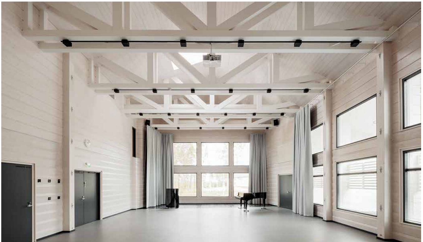
Kuva 7. Ruoveden seurakuntakeskuksessa hirsiprofiili on epäsymmetrinen ulko- ja sisätilojen välillä. Sisäpuolella osa hirsistä on muotoiltu kaltevaksi osana akustista suunnittelua äänten heijastuksien ohjaamiseksi.
