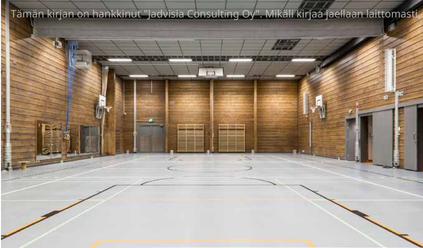
Kuva 35. Pudasjärven hirsikampuksen liikuntasalissa kaksi kerrosta korkeiden kantavien hirsiseinien jäykisteenä on risteävien seinien lisäksi liimapuiset tukipilarit noin 4 metrin välein. Pystykuormien lisäksi myös tuulikuormat aiheuttavat tarvetta jäykistykselle.
