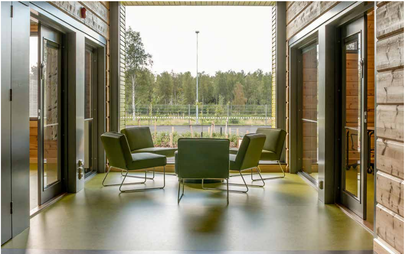
Kuva 15. Hirsirakenteisen kantavat seinät -järjestelmän ominaispiirteet voivat toimia arkkitehtuurin lähtökohtana. Eräs luonteva toteutus-tapa kantavaseinäisen hirsirakennuksen suurille aukoille on toteuttaa ne kahden itsenäisen, kantavan ja jäykistävän hirsirakenteen väliin. Pudasjärven hirsikampuksessa kahden hirsikehän väli on kokonaan lasia.
